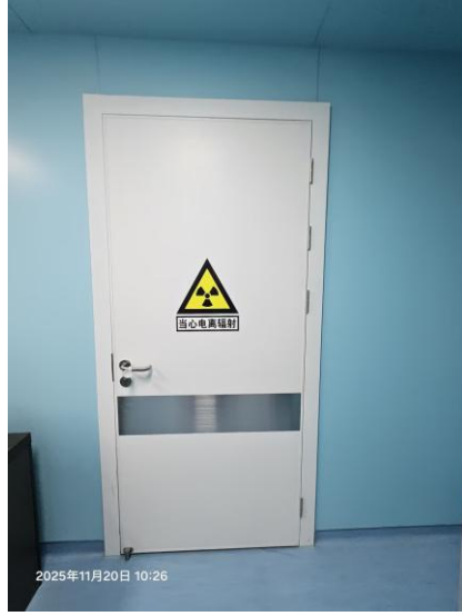
控制室防护门
